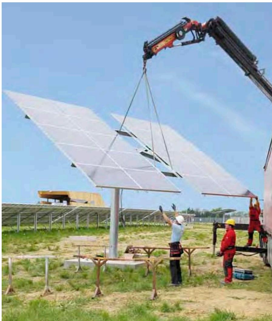
Mit 1.050 kW installierter Leistung ist der "SolarCampus" der Energie AG Oberösterreich Fair Energy GmbH an der Westautobahn bei Eberstallzell in Oberösterreich das größte Photovoltaik Kraftwerk im Bundesgebiet und zugleich Forschungsanlage. Feststehende Paneele mit Solarmodulen verschiedener Bauformen und Hersteller werden von sechs Sonnenfolgern ergänzt. Mit deren um bis zu 40% besserer Ausbeute werden 5% der Energie erzeugt.
