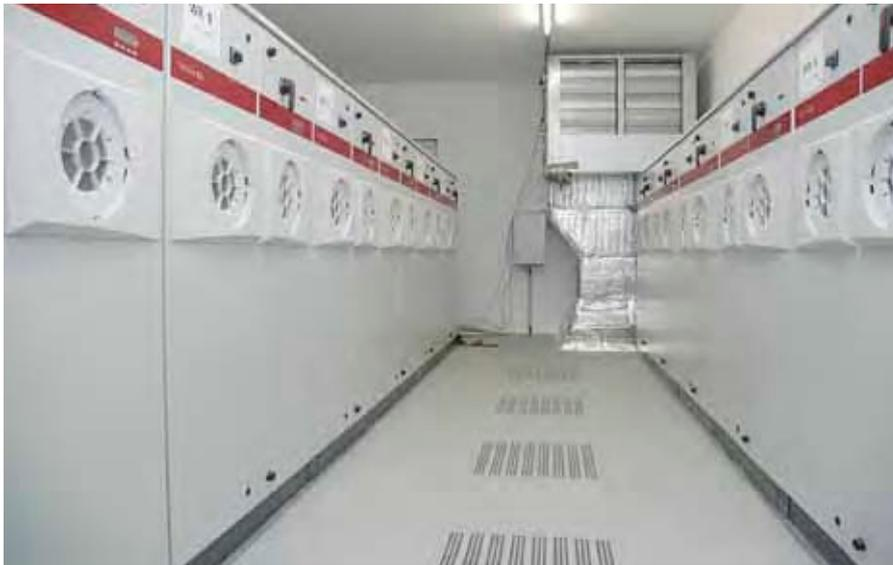
Elektrotechnisches Kernstück der Anlage ist die Batterie von netzgekoppelten Wechselrichtern. Sie wurden über ihre RS 485 Schnittstelle in die Leittechnik integriert.
