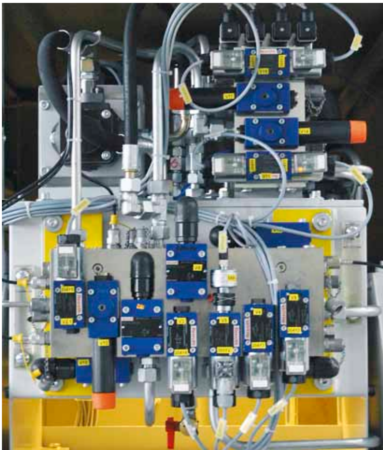
Einfacher als zur Proportionaltechnik fällt die Hydraulik aus: Power Panel übernimmt Steuerung und beschleunigt die Entwicklung.
