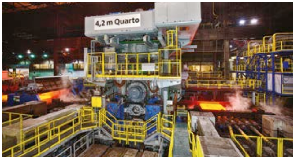
Dieses Quarto-Walzgerüst ist das Herzstück der Grobblechproduktion des Stahlherzegers voestalpine Grobblech. Es ersetzte nach mehr als 57 Jahren eine Vorgängeranlage und wurde in Rekordzeit in Betrieb gesetzt.
