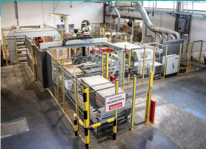
Für das Werk Weiz des österreichischen Herstellers Weitzer Parkett schuf Willingshofer eine vollautomatische Linie für die Produktion der gesamten Palette an Parkett-Fußbodenbrettern mit einem Ausstoß von 360 Stück pro Minute.
