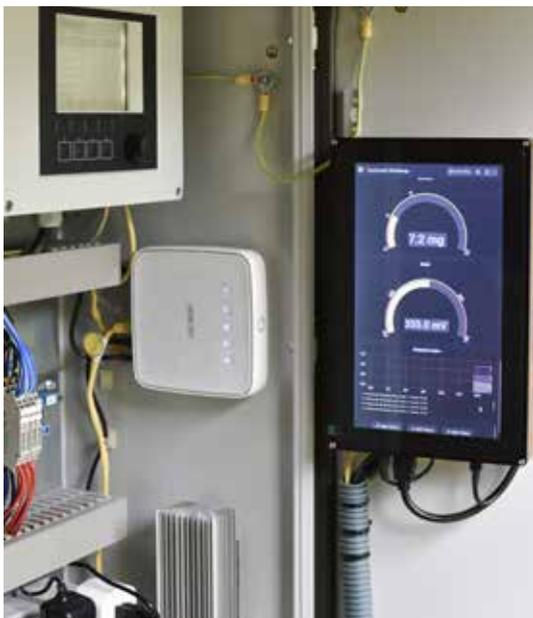
Messtechnisches Herzstück der Anlage ist der digitale Multiparameter-Messumformer Liquiline CM444.
