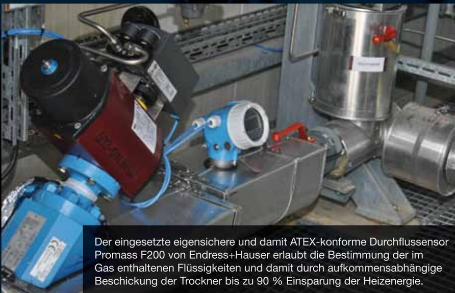
Der eingesetzte eigensichere und damit ATEX-konforme Durchflusssensor Promass F200 von Endress+Hauser erlaubt die Bestimmung der im Gas enthaltenen Flüssigkeiten und damit durch aufkommensabhängige Beschickung der Trockner bis zu 90 % Einsparung der Heizenergie.
