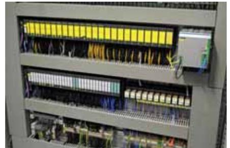
„Gelbe“ Peripherie dominiert die dezentralen Schaltschränke. Über Profibus sind sichere wie nicht-sichere Technik mit den SIMATIC Bundles vernetzt.
