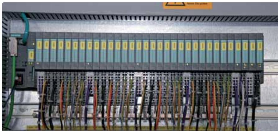
Die Ausstattung der Zehn Stationen erfolgte mittels dezentraler Peripheriesysteme SIMATIC ET 200S.
