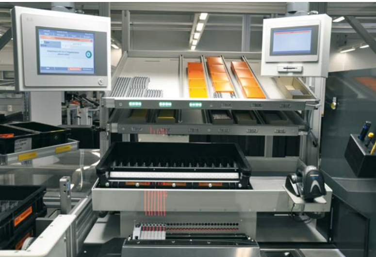
Auftragsbezogen wird die Steuerung assembliert. Der Prozess wird mit Pick-by-Light-Systemen unterstützt.
