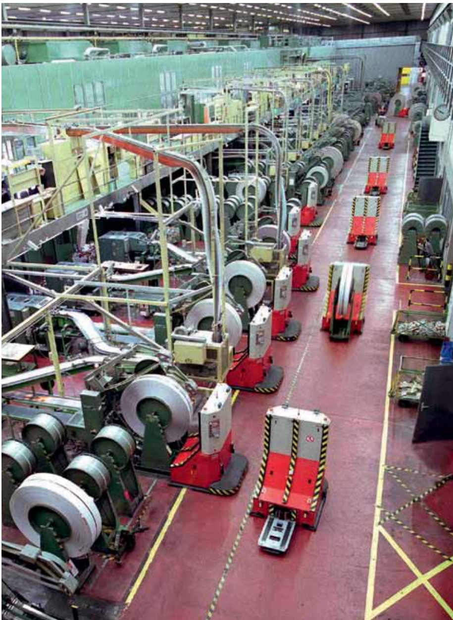
Die erste größere FTS-Anlage von DS Automation für eine Branche außerhalb der Automobilindustrie transportierte bei Axel Springer Printrollen von der Tiefdruckmaschine in ein Pufferlager und dann weiter zur Heftmaschine.
