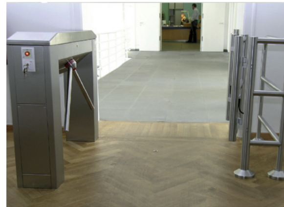
Asymmetrische Zweiarm-Dreh Sperren haben ohne zusätzliche bewegliche Teile eine Stellung, in der kein Holm den Durchgangsweg versperrt.
