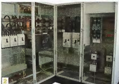
1 Stufenlose Kontaktierung bei Maxi-PLS, oben für 3.200 A, unten für 2.000 A
