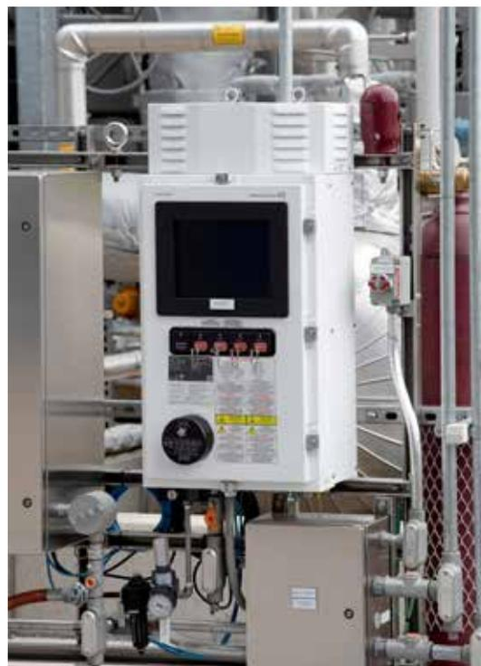
**Wesentlich schneller als herkömmliche Gas-Chromatografen** ermöglicht der kompakte, für den Ex-Bereich zertifizierte Raman-Rxn5- Prozessanalysator eine sichere Analyse von Gasen.
