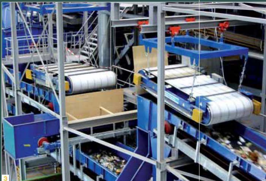
3 Überbandmagnete in der Müllaufbereitung – Metall wird angezogen und ausgeschleust.
